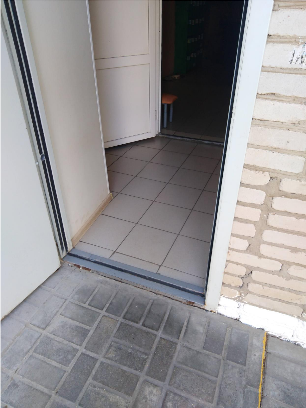
Фото 4. «Вход в здание МБДОУ ЦРР – ДС»
